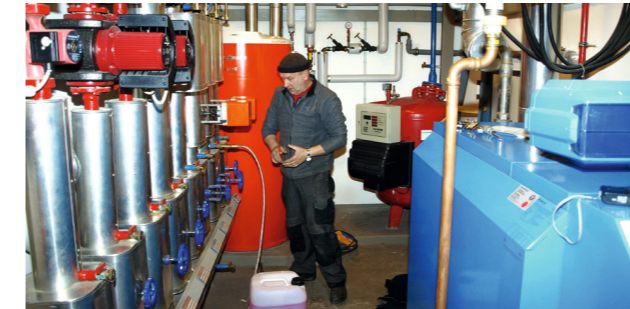
Das Einfüllen von Heizungsblut® – unkompliziert und sauber durch einen Profi.
